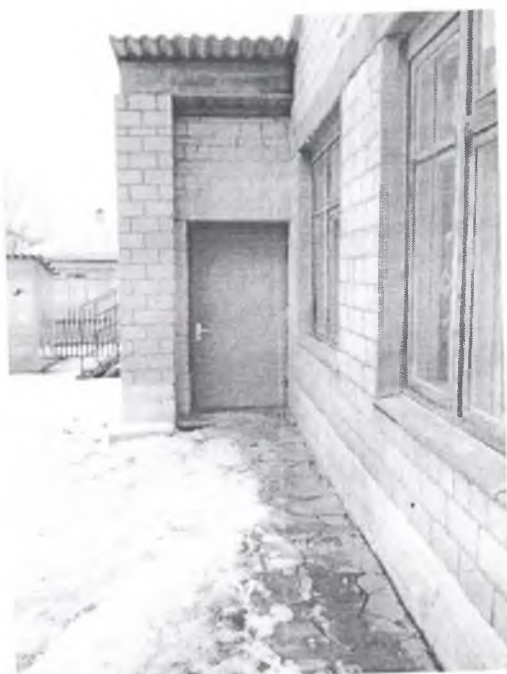
Фото №13. Пути эвакуации
