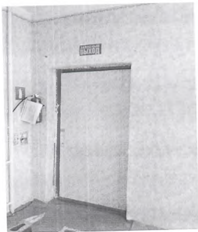
Фото №1. Пути эвакуации
