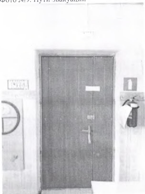
Фото №9. Пути эвакуации
