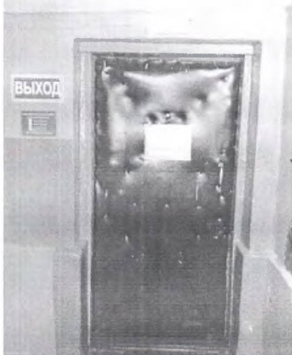
Фото №6. Дверь входная.
