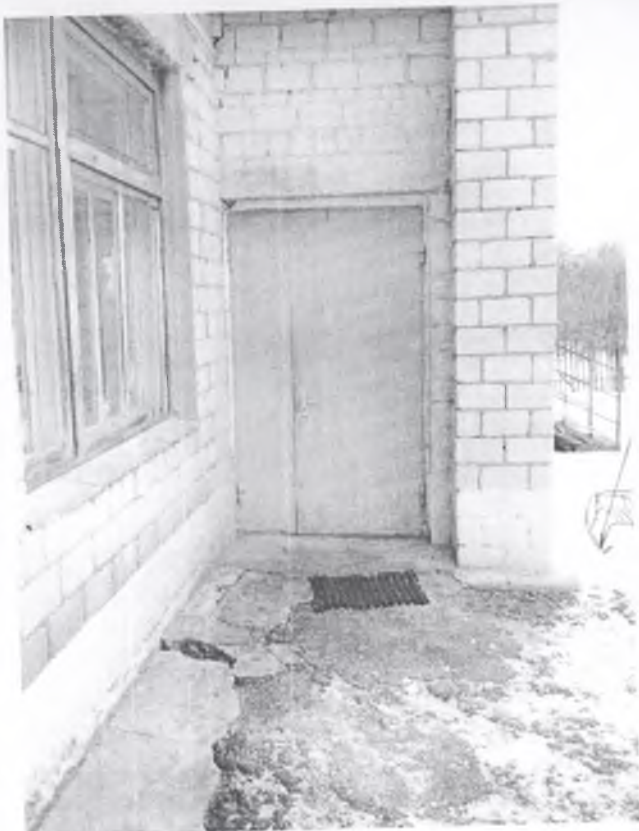
Фото №12. Пути эвакуации
